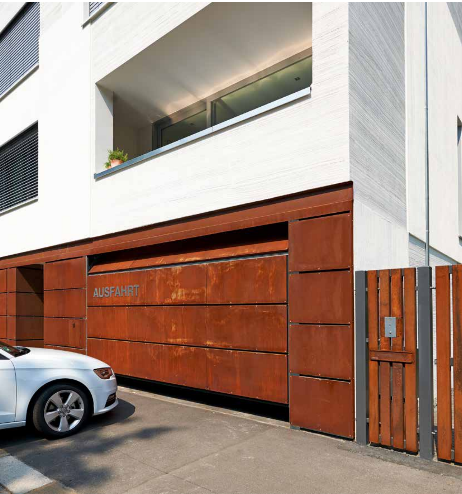
Облицовка ламинированными панелями, выполняемая заказчиком
