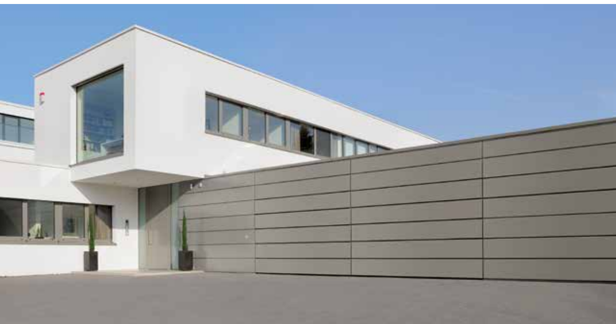
Облицовка алюминиевой соединительной пластиной, выполняемая заказчиком
