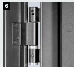
Простая замена петельных роликов на дверном полотне (на рис.: многофункциональная дверь OD)
